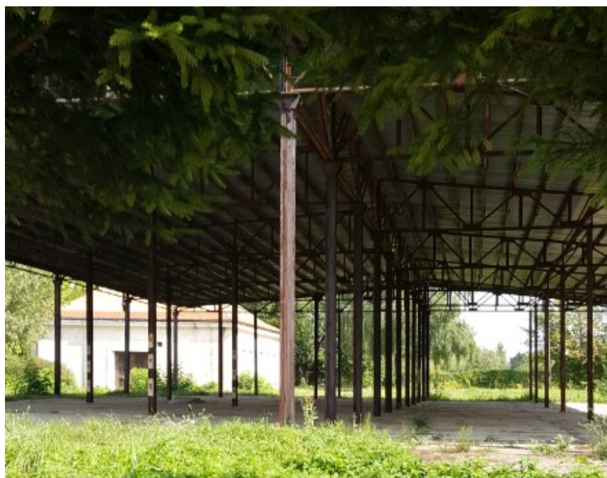
Rys. 2 Widok na układ słupów wiaty
