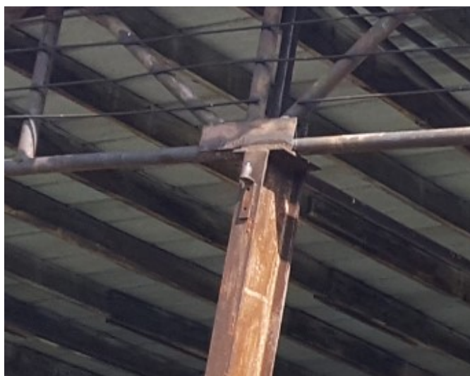
Rys. 6 Widok na podporę kratownicy na słupie I220
