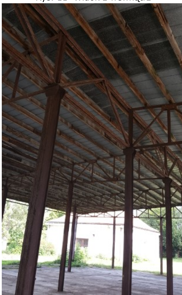
Rys. 12 Widok na konstrukcję wsporcą dachu
