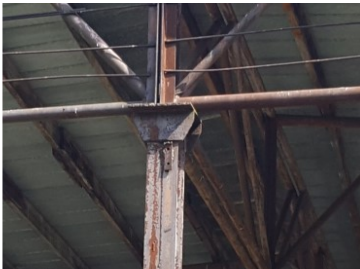
Rys. 5 Widok na podporę kratownicy na słupie 2C160
