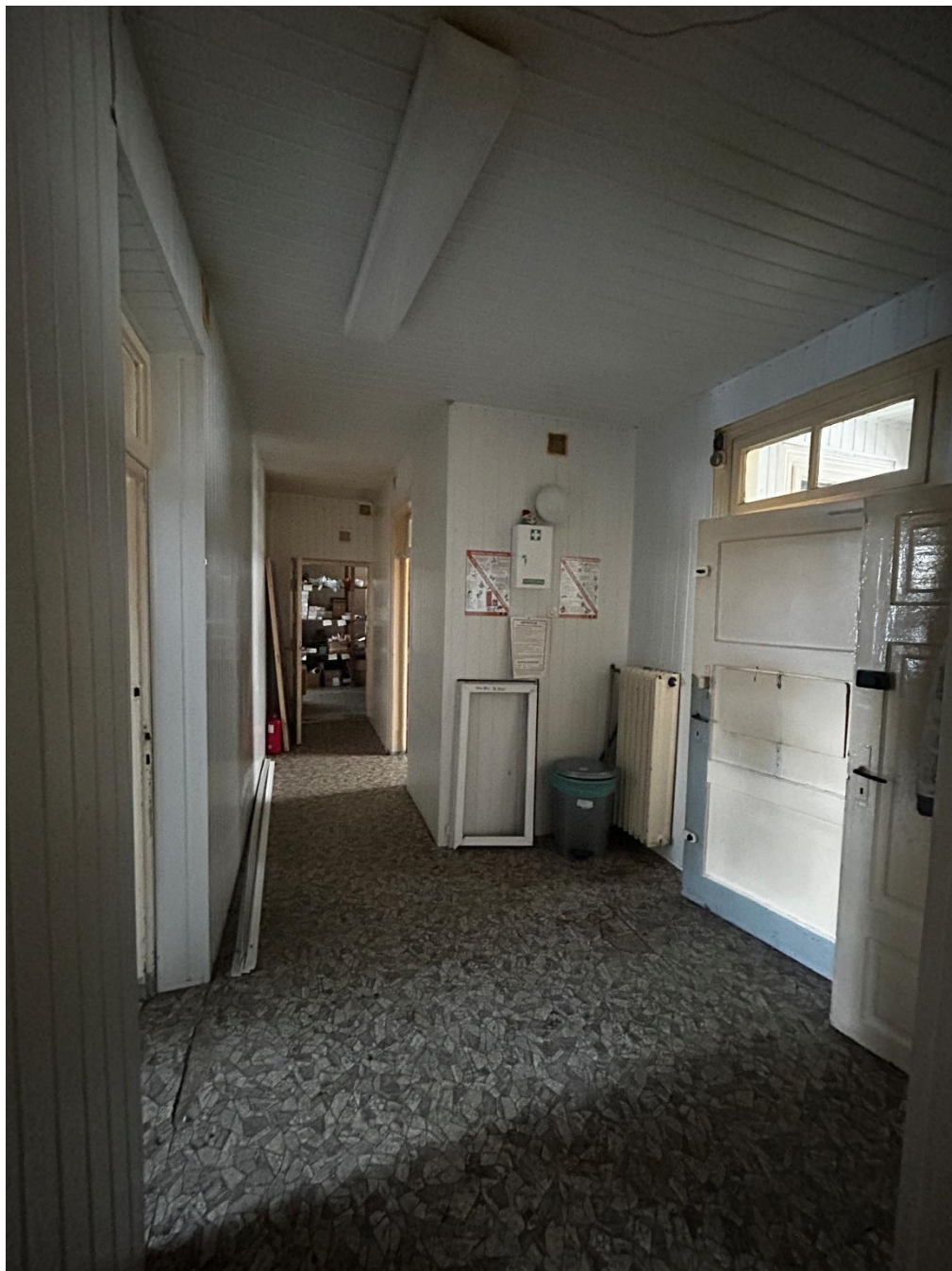
Zdjęcie 5. Pomieszczenie nr 02 /patrz rzut budynku/
