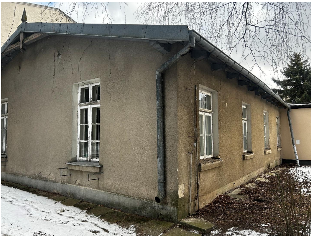
Zdjęcie 3. Elewacja budynku od strony zachodniej
