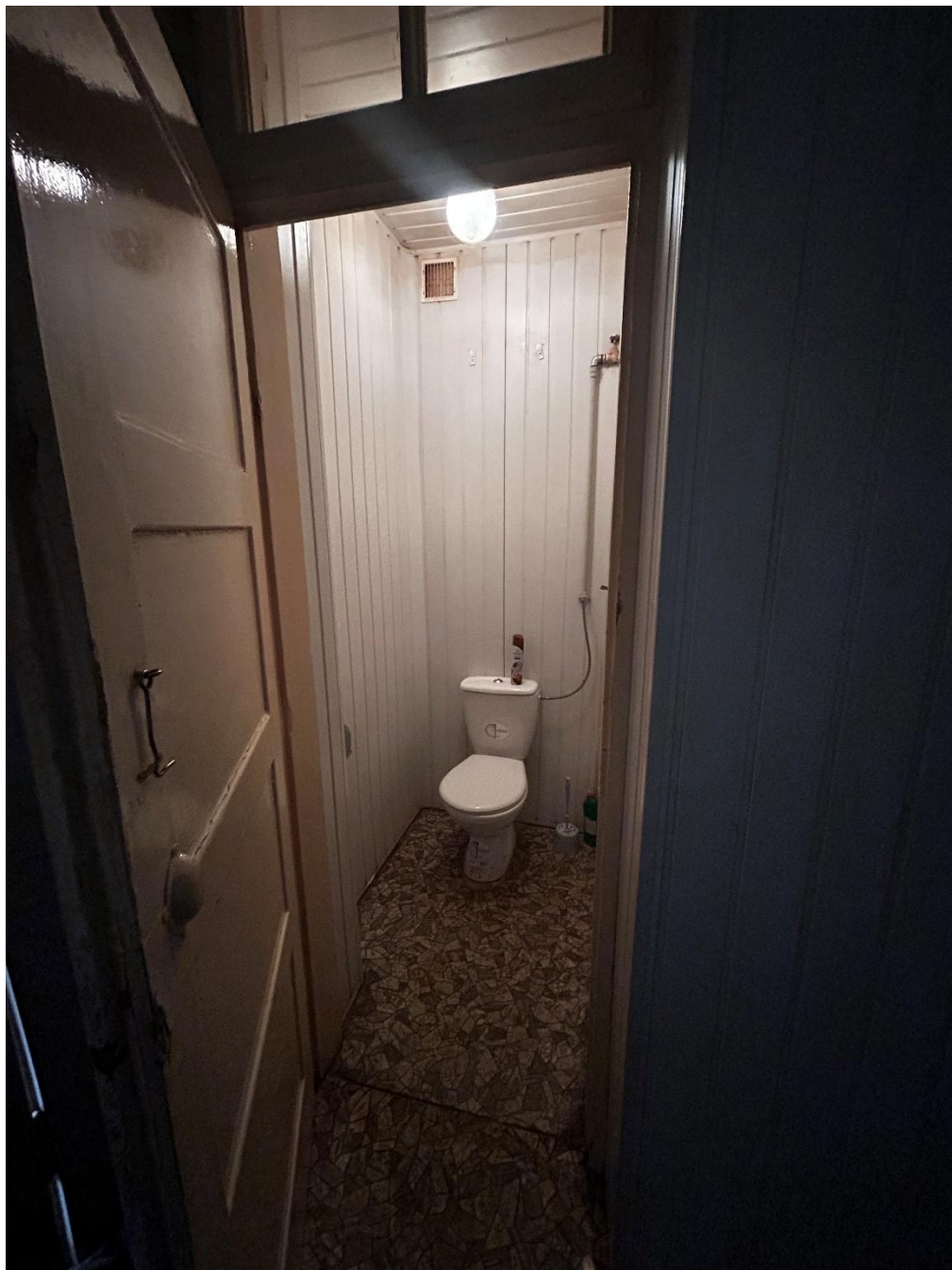
Zdjęcie 7. Pomieszczenie nr 07 /patrz rzut budynku/
