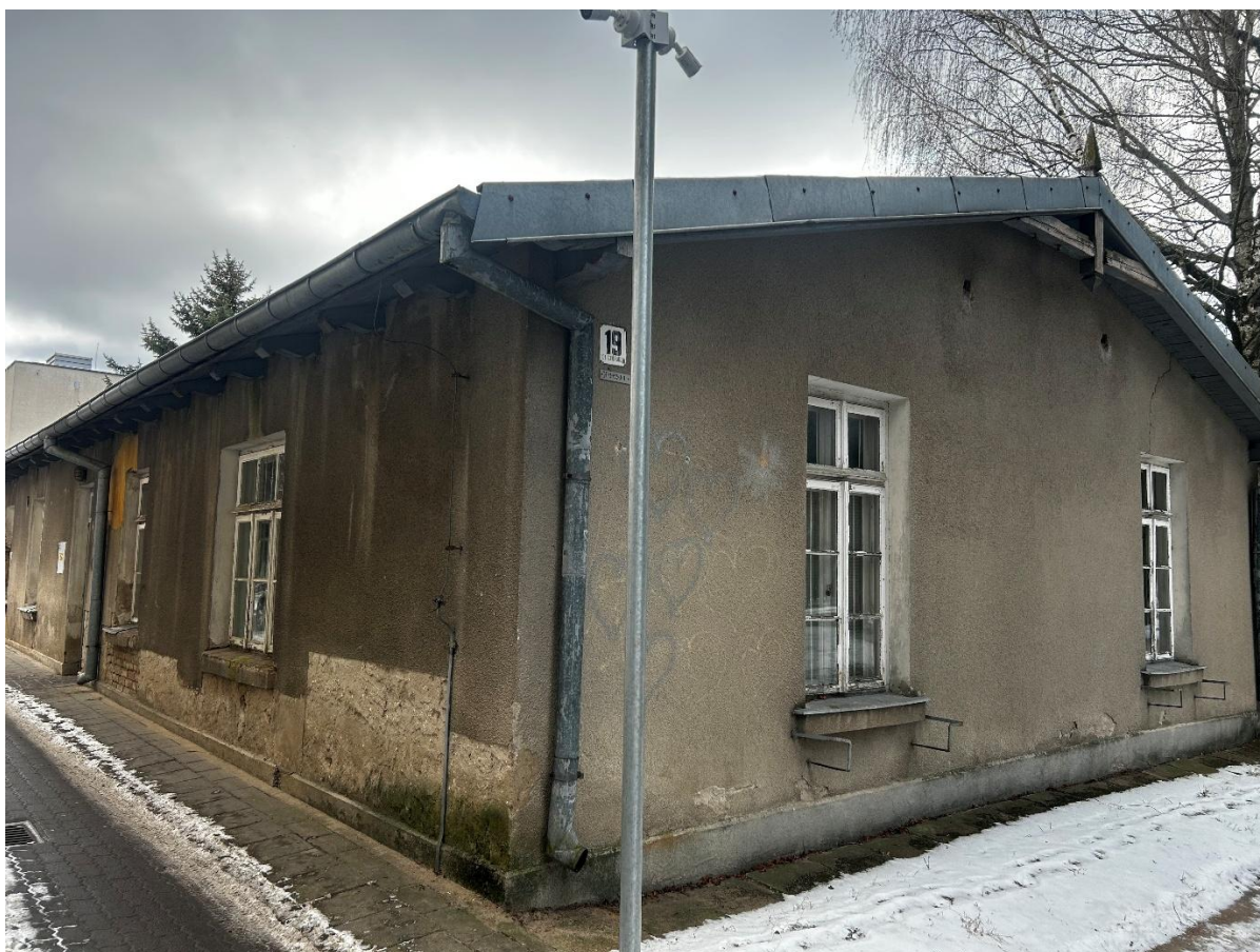
Zdjęcie 2. Elewacja budynku od strony północnej
