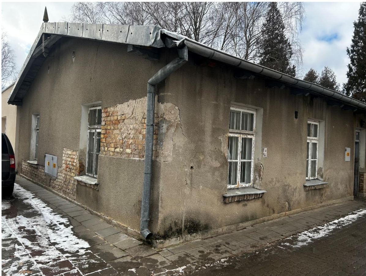
Zdjęcie 1. Elewacja budynku od strony wschodniej
