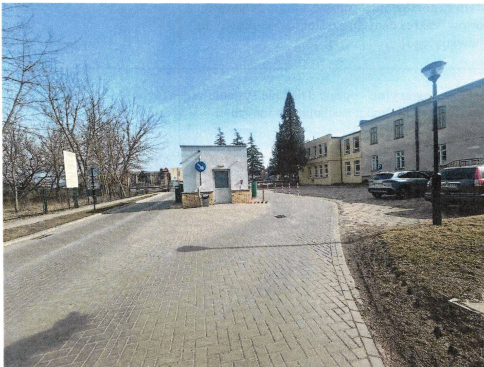
Obecny system parkingowy z portiernią do Szpitalu w Choroszczy
